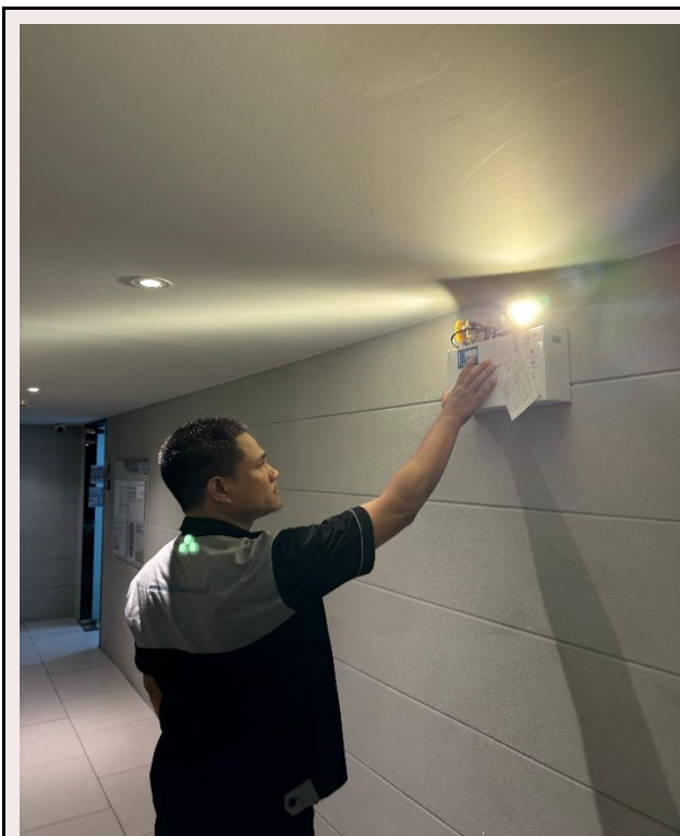
ภาคผนวกที่ 3.17 การตรวจสอบระบบไฟสำรอง
