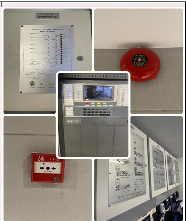
ภาคผนวกที่ 3.16 การตรวจสอบระบบเตือนอัคคีภัย
