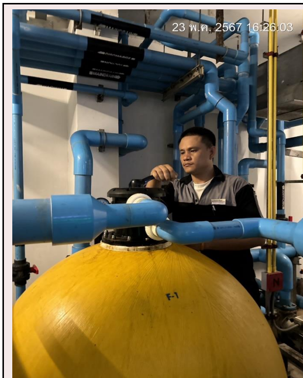
ภาคผนวกที่ 3.29 การทำความสะอาดระบบกรองสระน้ำ
