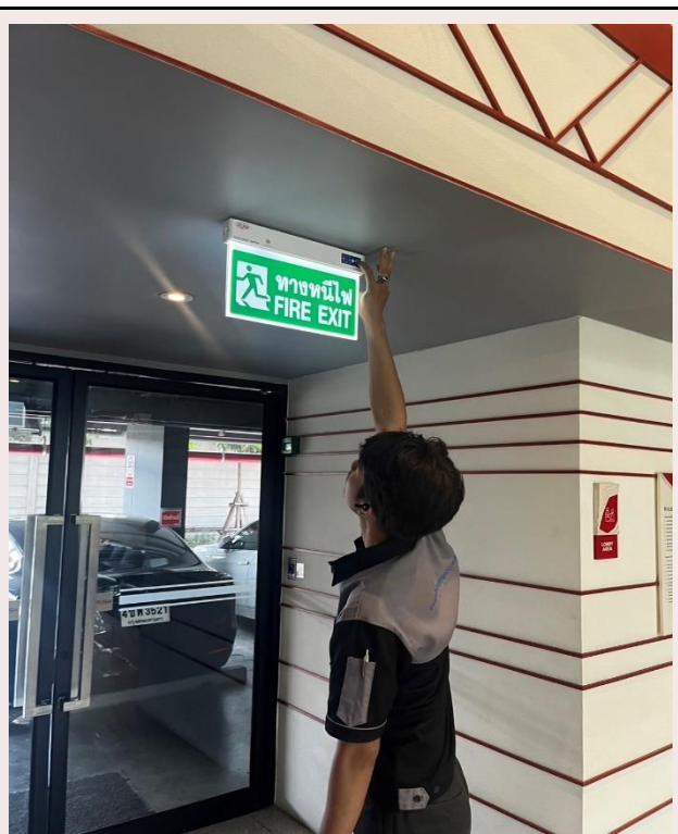
ภาคผนวกที่ 3.18 การตรวจสอบป้ายทางออกฉุกเฉิน
