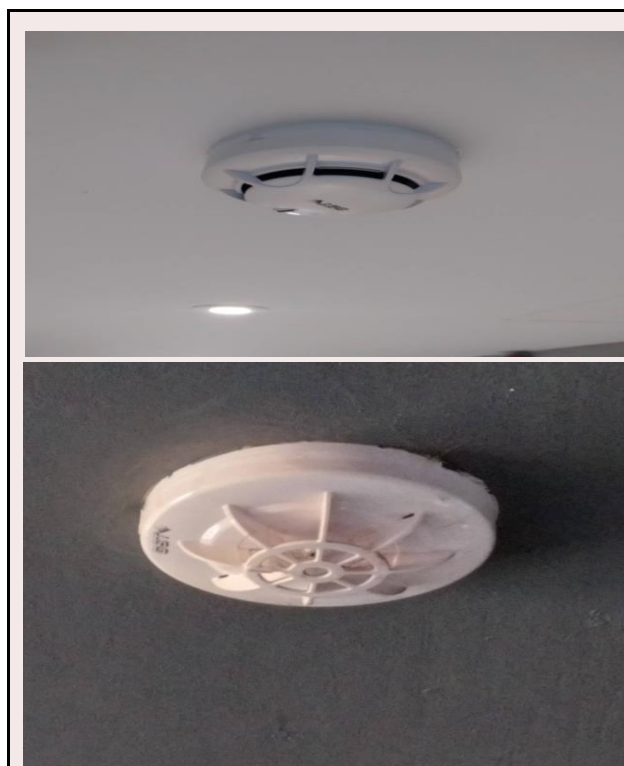
ภาคผนวกที่ 3.43 Smoke&Heat detector
