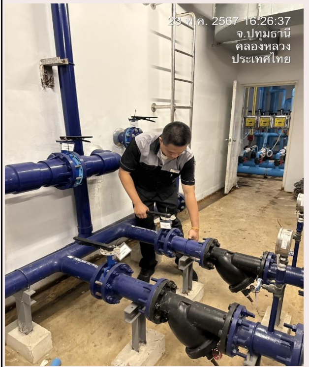
ภาคผนวกที่ 3.26 ตรวจสอบวาล์วเปิด-ปิด ถังเก็บน้ำ
